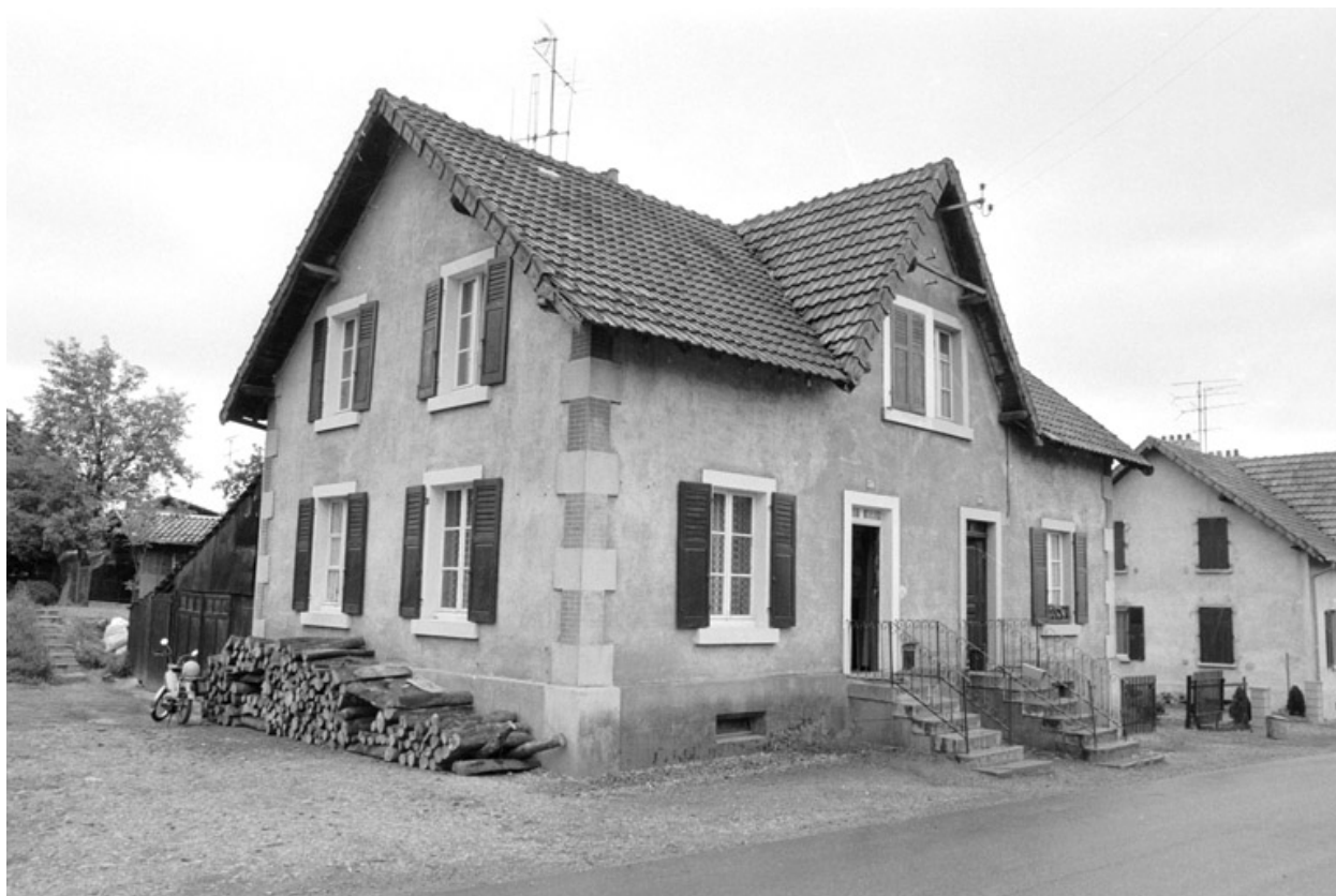
Maison à deux logements rue Bellevue en 1980.
