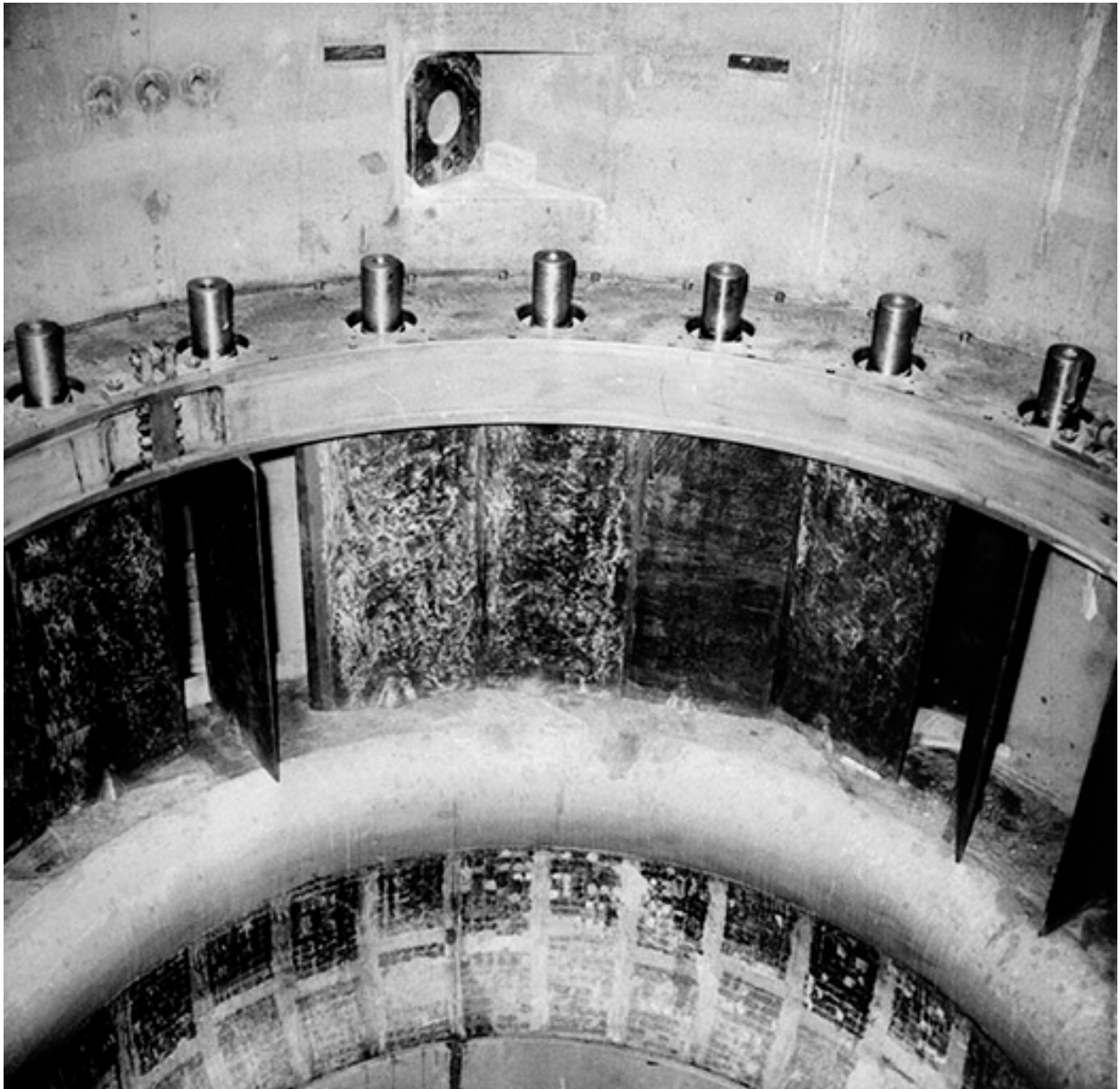
Turbine G.1 : distributeur en cours de montage.
