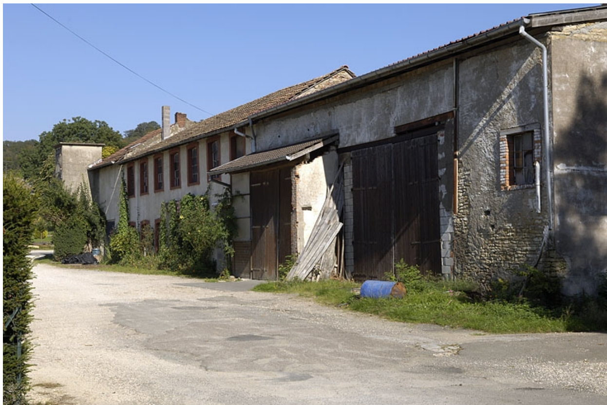
Atelier de boissellerie vu depuis la rue.
