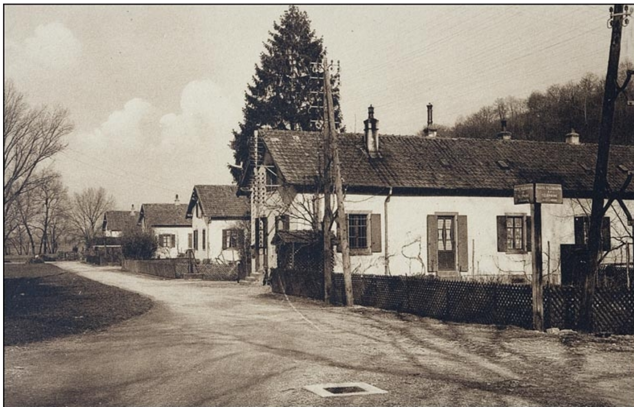
Cité ouvrière, rue de la Poste.
