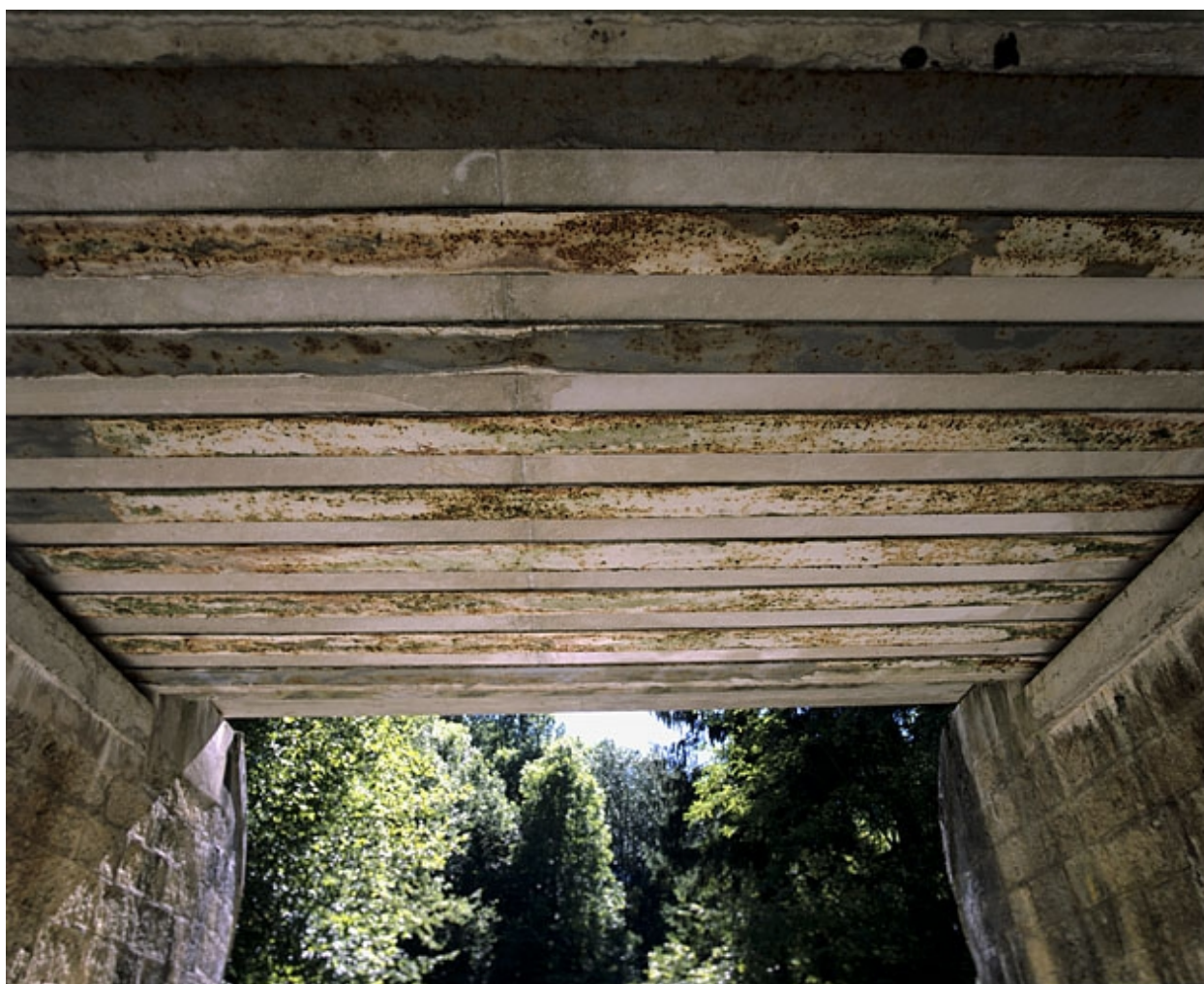
Pont : poutrelles en face inférieure du tablier.
