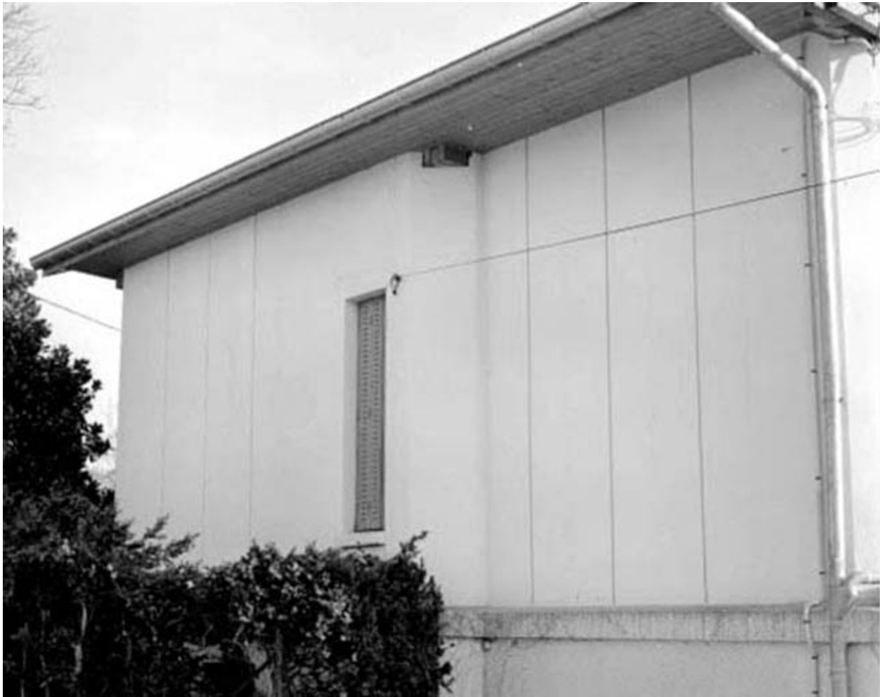
Façade latérale gauche : détail du mur.
