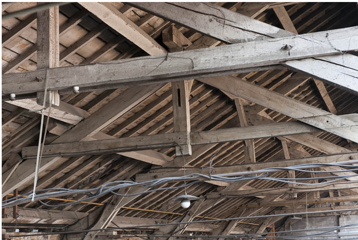
Détail de la charpente du magasin industriel.
