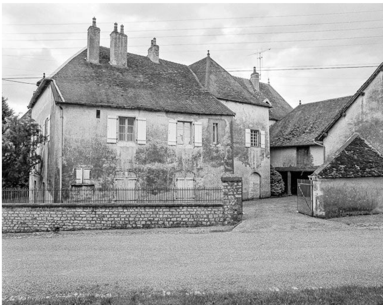
Demeure située rue de l'Eglise.
