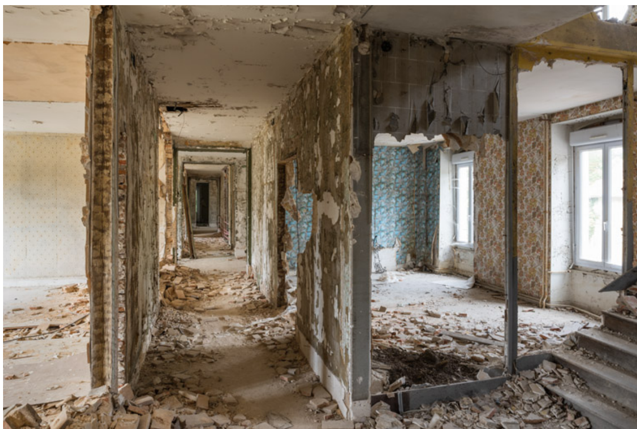
Couloir et chambres au premier étage.
