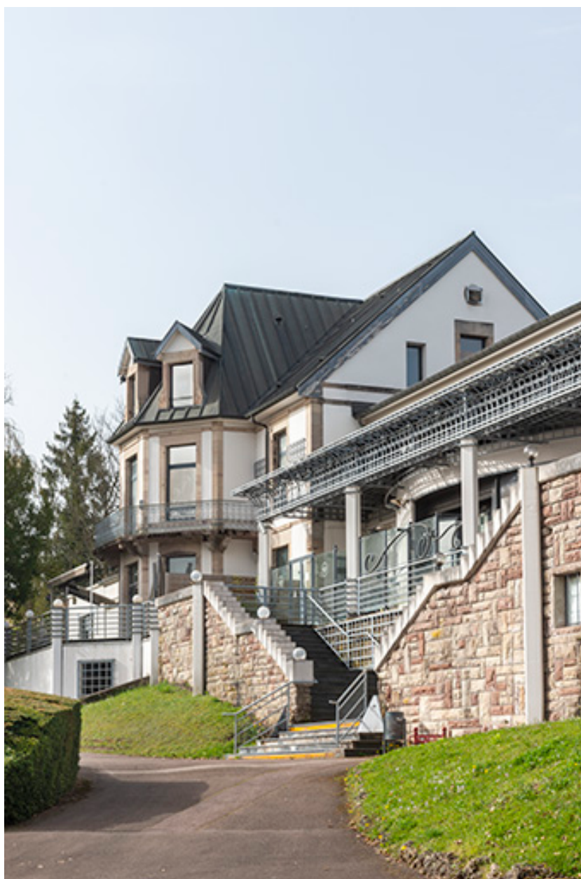
Maison, vue depuis le nord.
