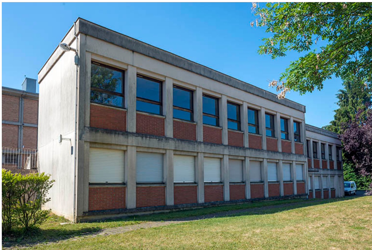
Façades antérieures (nord) du bâtiment d'externat. (ex-Garnier)
