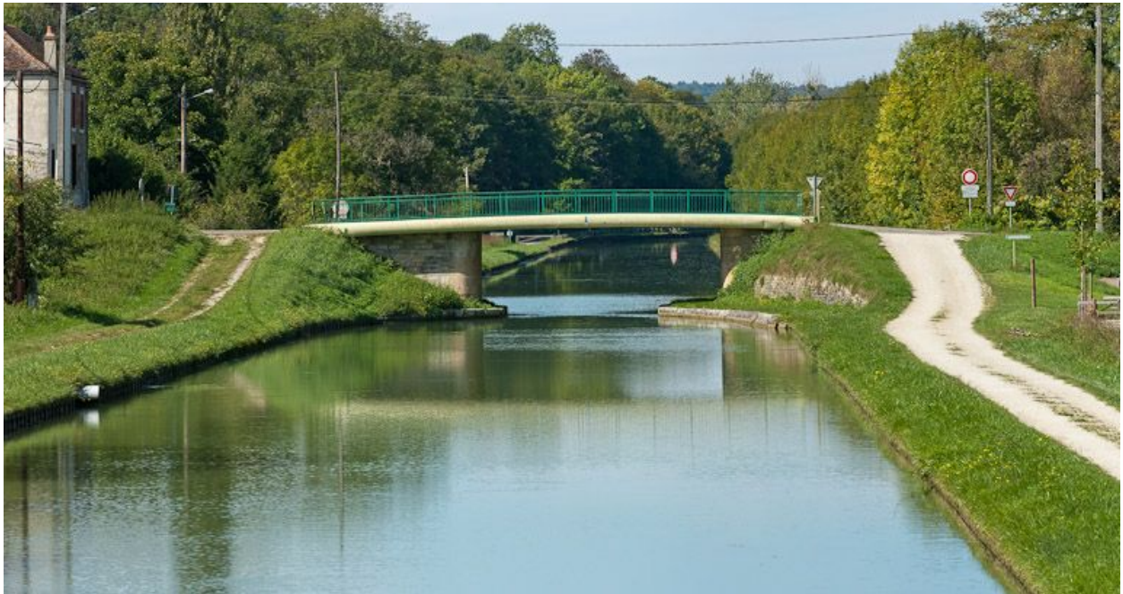
Vue du pont.
