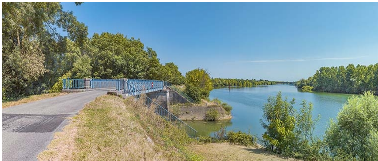
Le pont sur la Dheune, vu d'aval.
