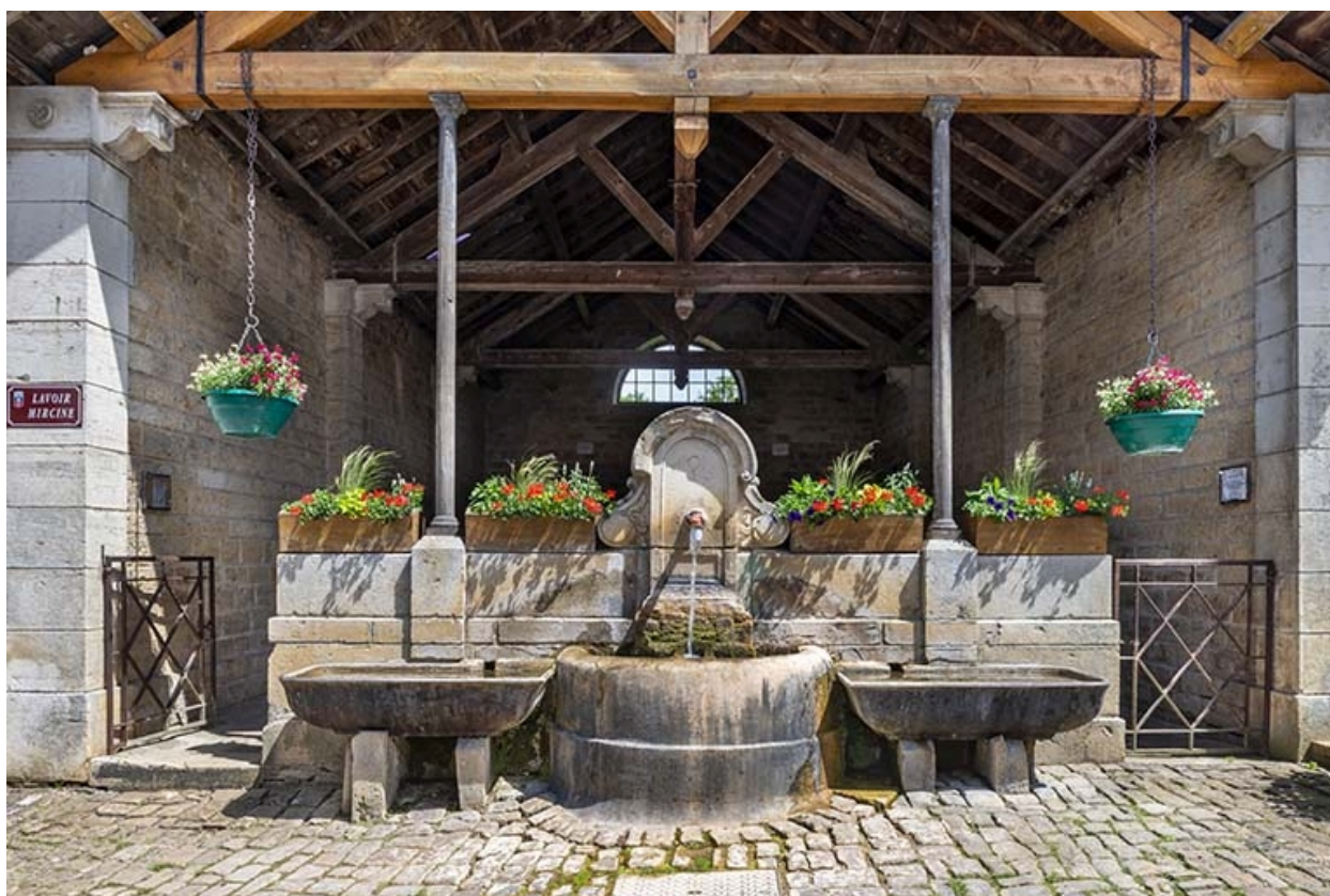
Détail de la face antérieure du lavoir.
