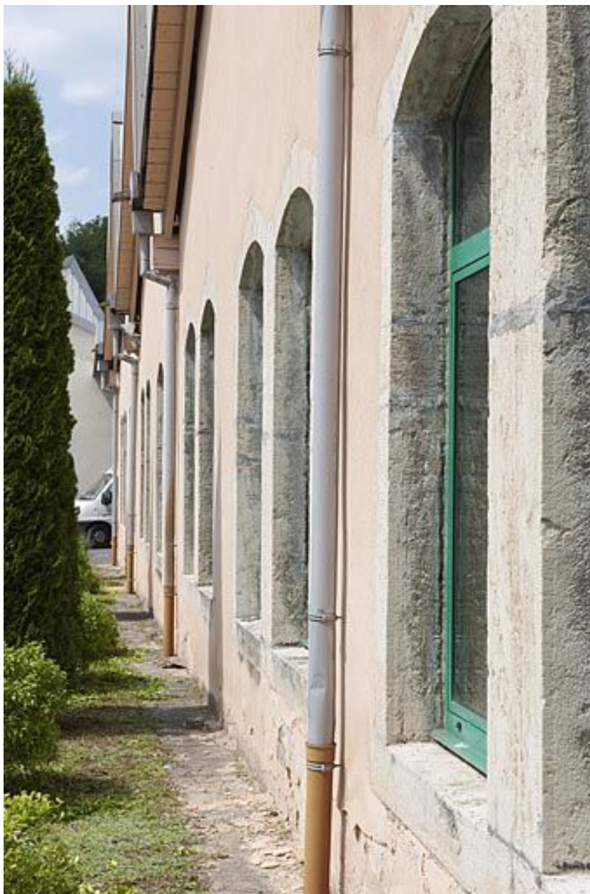
Façade ouest de l'atelier d'outillage.
