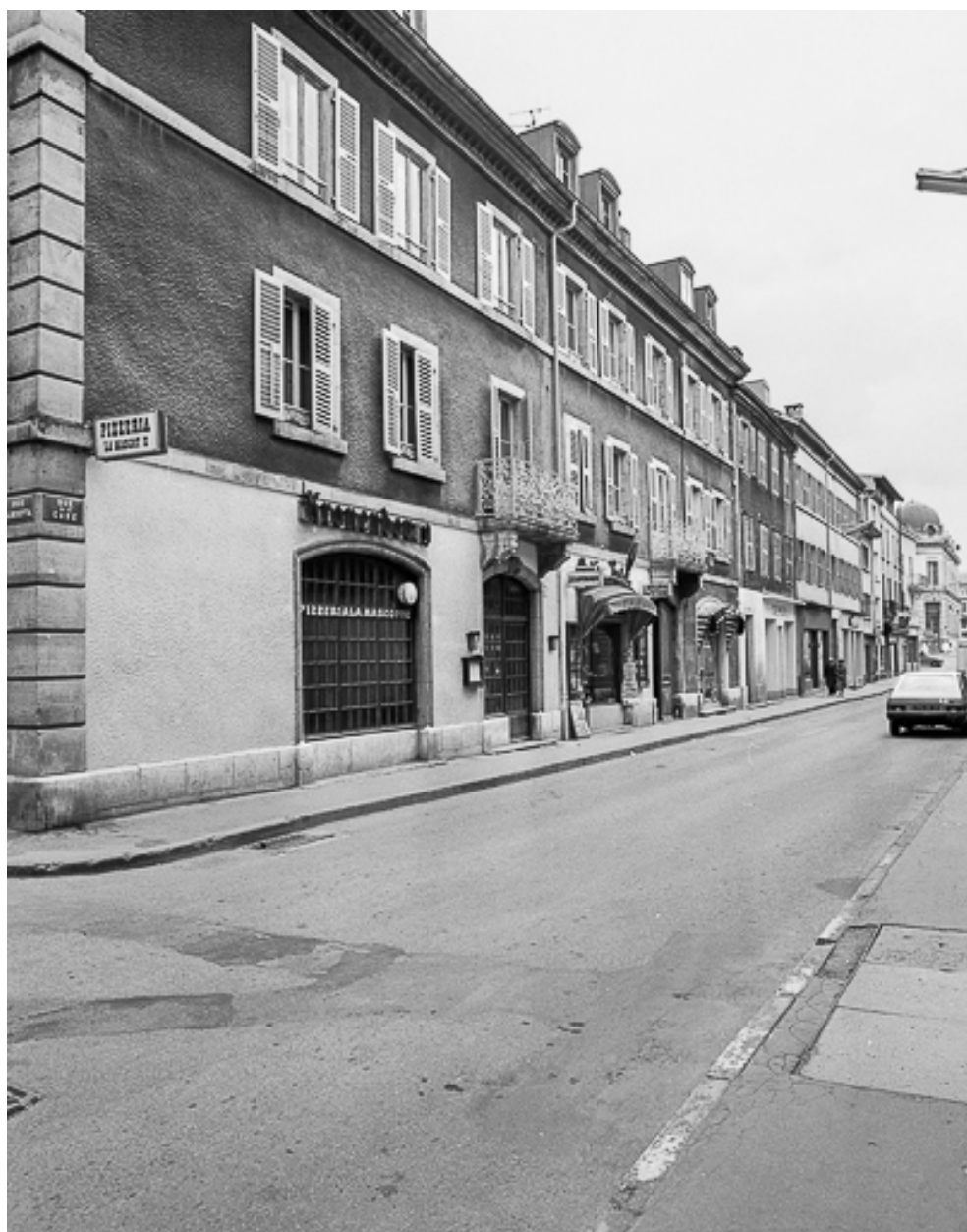
Maisons situées rue de la Gare.
