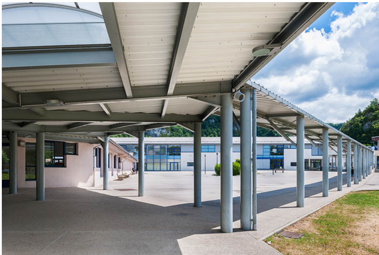
Passage entre internat et restauration.
