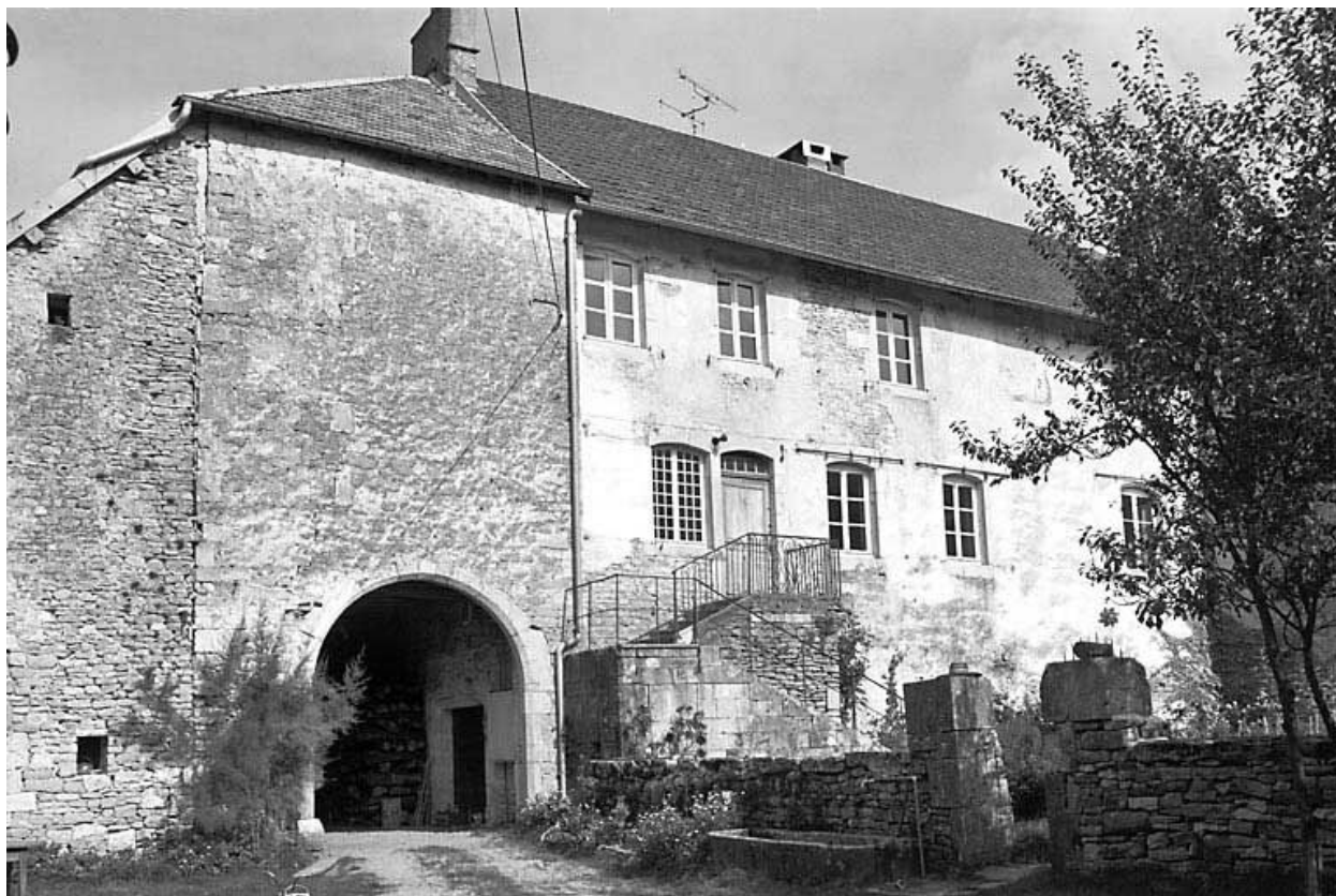
Façade antérieure et le passage voûté.
