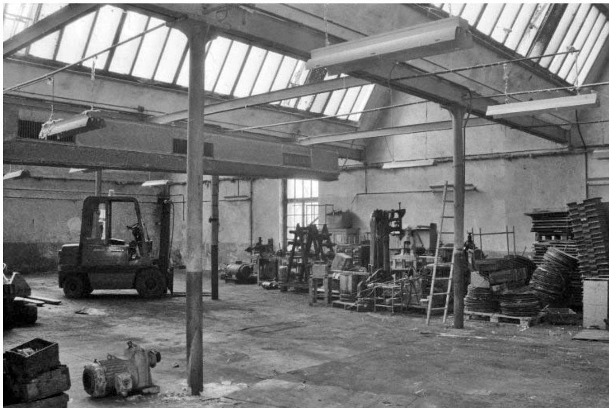
Vue intérieure des ateliers couverts en shed.
