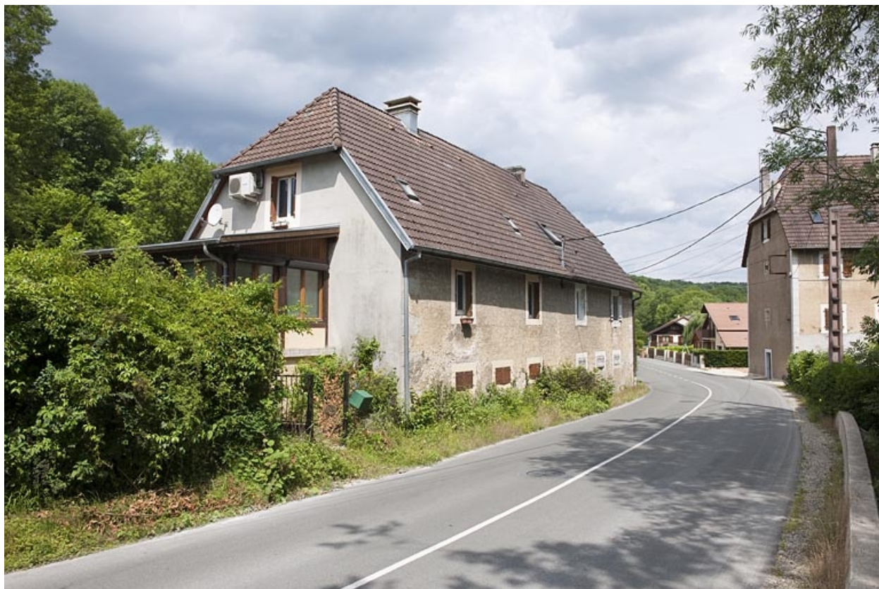
Logement d'ouvriers depuis le sud.
