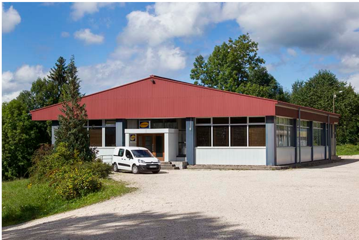
Façades antérieure et latérale droite.
