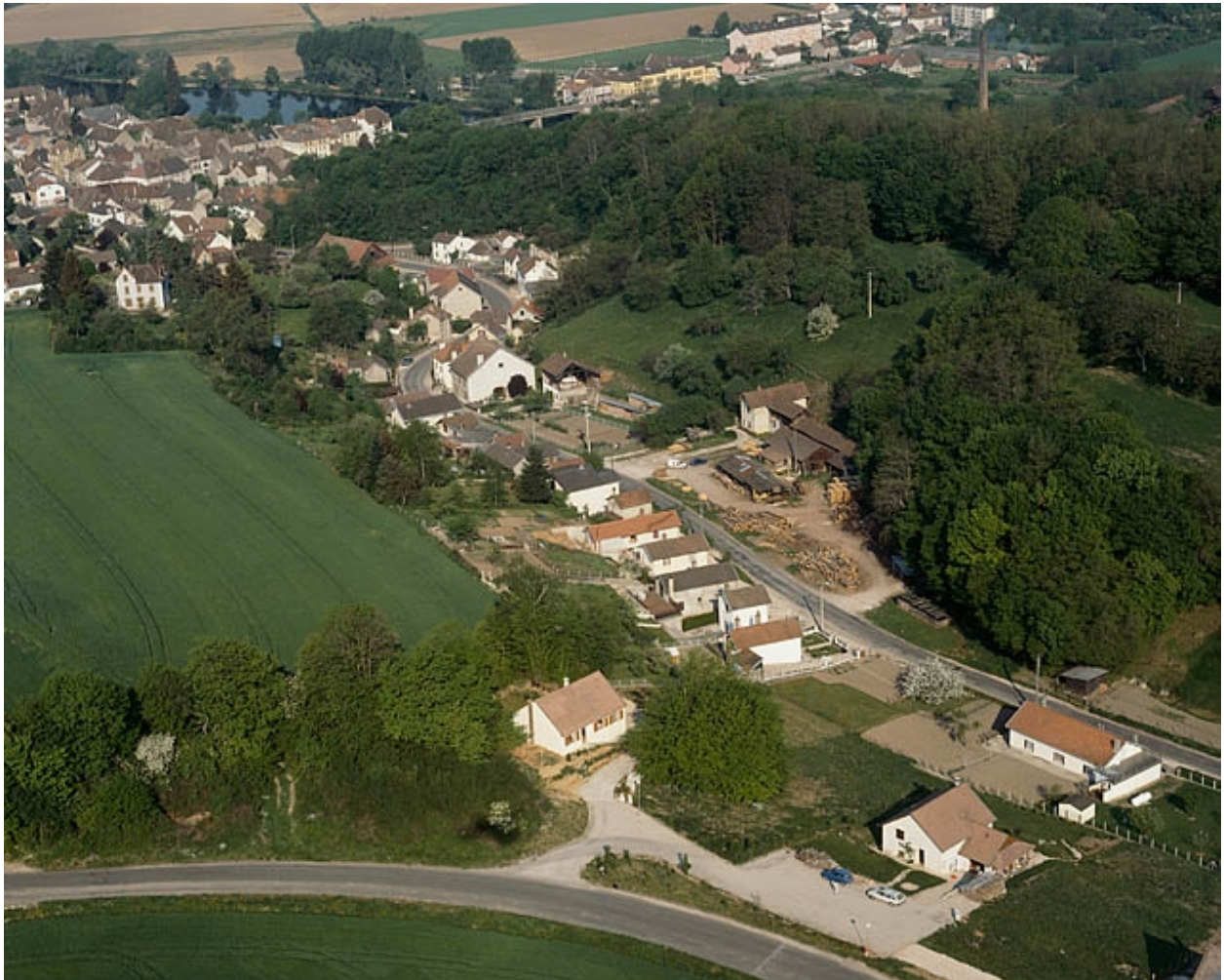
Vue d'ensemble depuis l'est, photographie aérienne.
