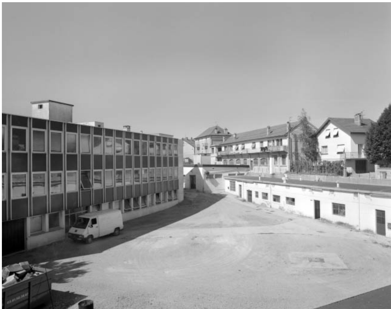
Vue plongeante sur la cour de l'usine.
