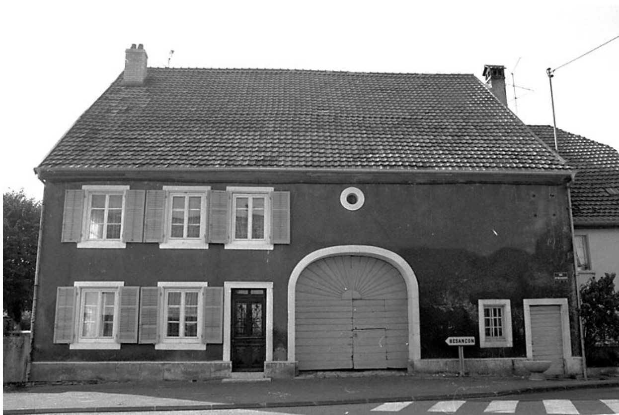
Ferme située 2 rue de Voujeaucourt.
