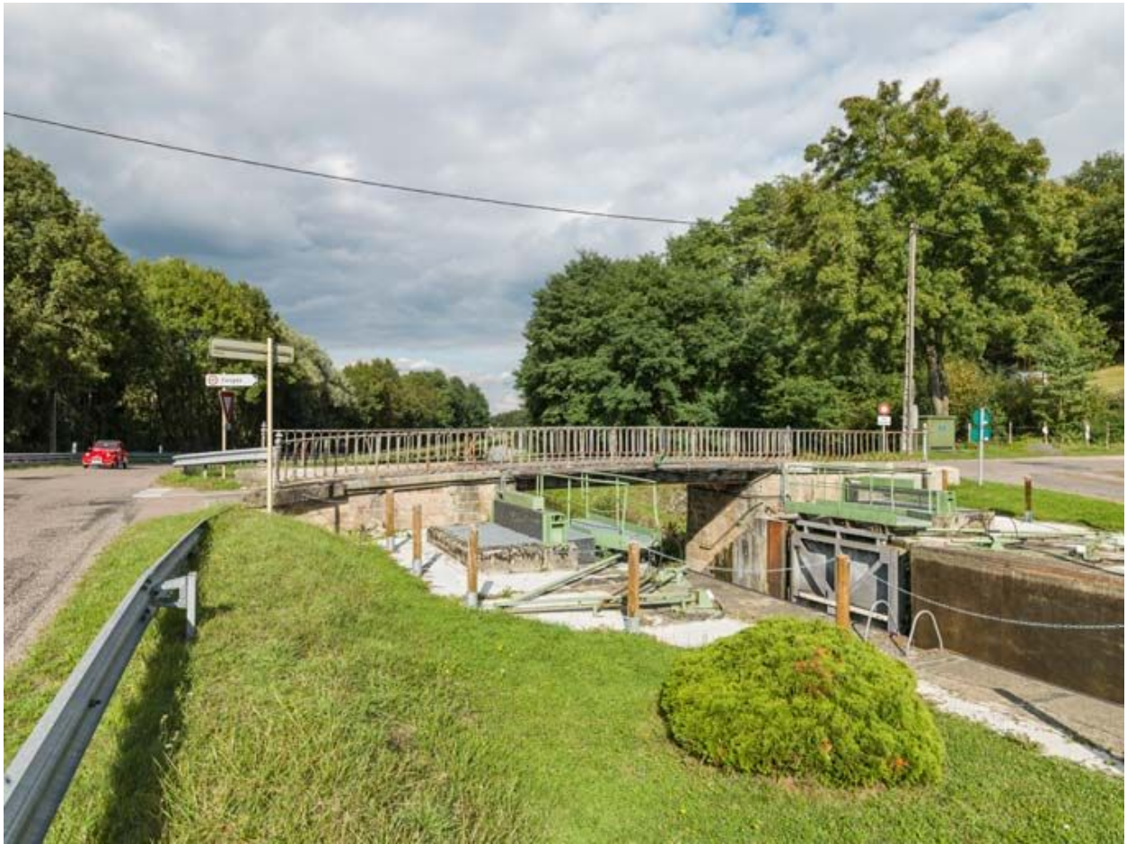
Vue d'ensemble du pont.
