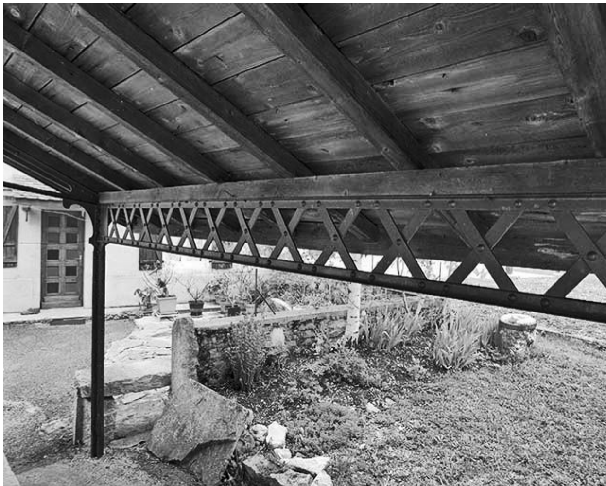
Détail de la panne sablière.
