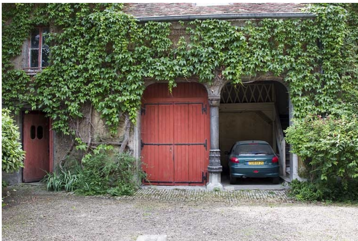
Bâtiment des remises : façade antérieure.
