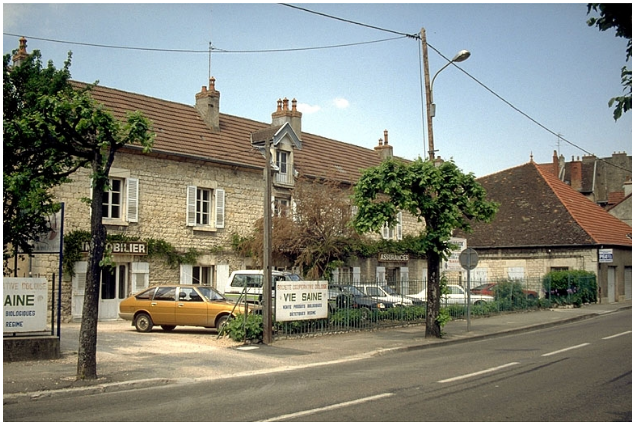
Bureau-logement patronal et magasin industriel (C).
