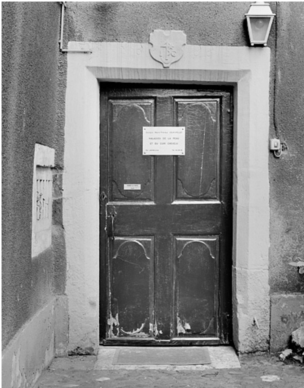
Porte de la tour d'escalier.
