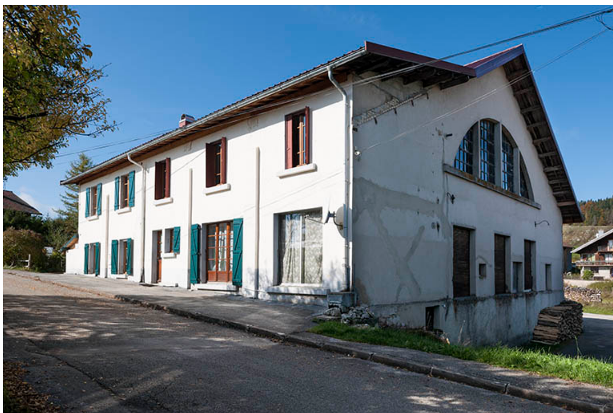
Vue depuis le sud.
