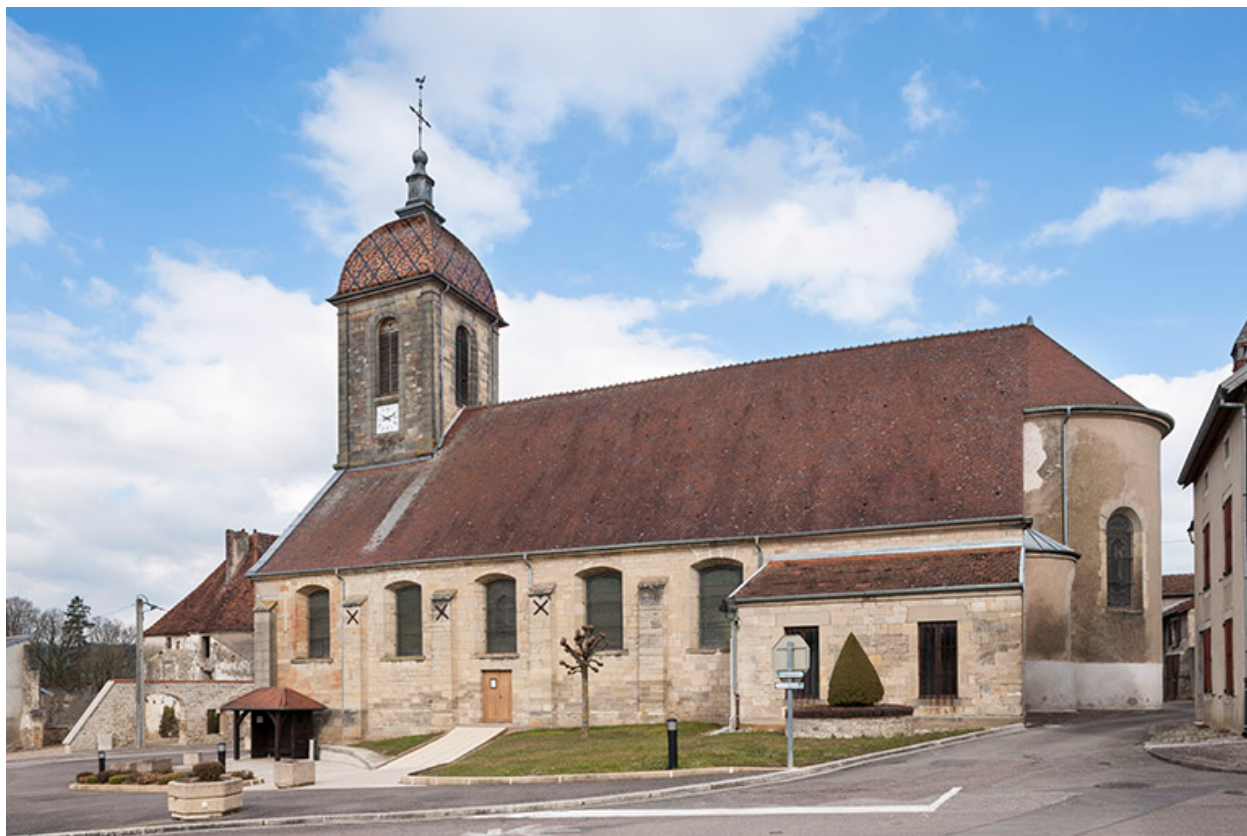
Vue de la façade sud.
