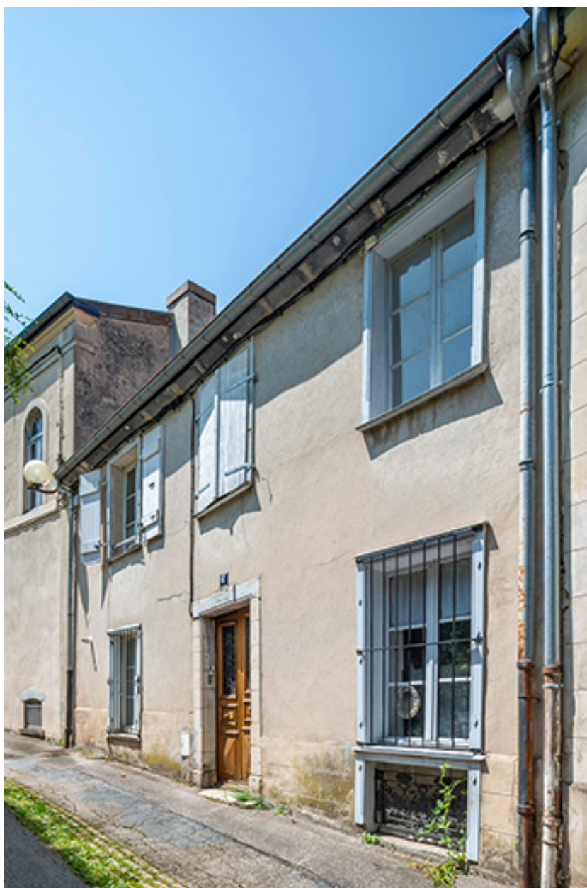
Façade vue de trois quarts droite.
