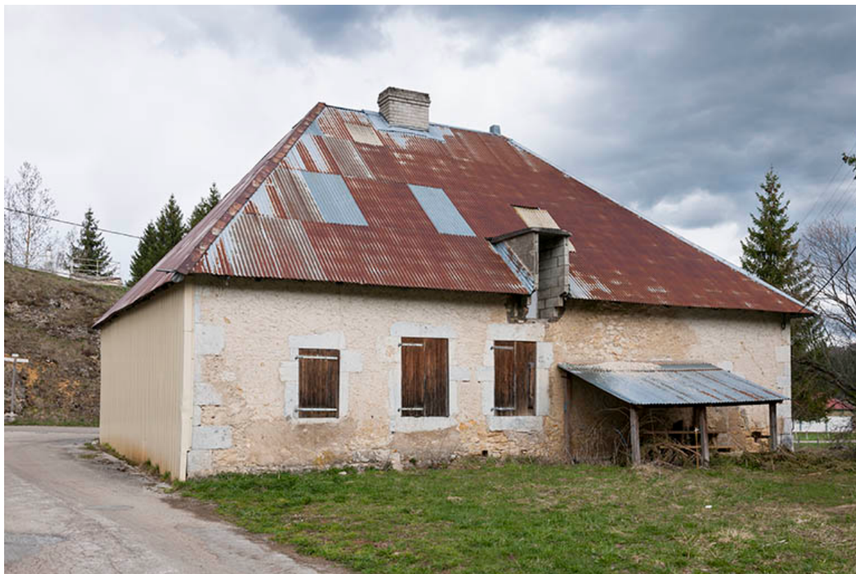
Façades postérieure et latérale droite en 2016.
