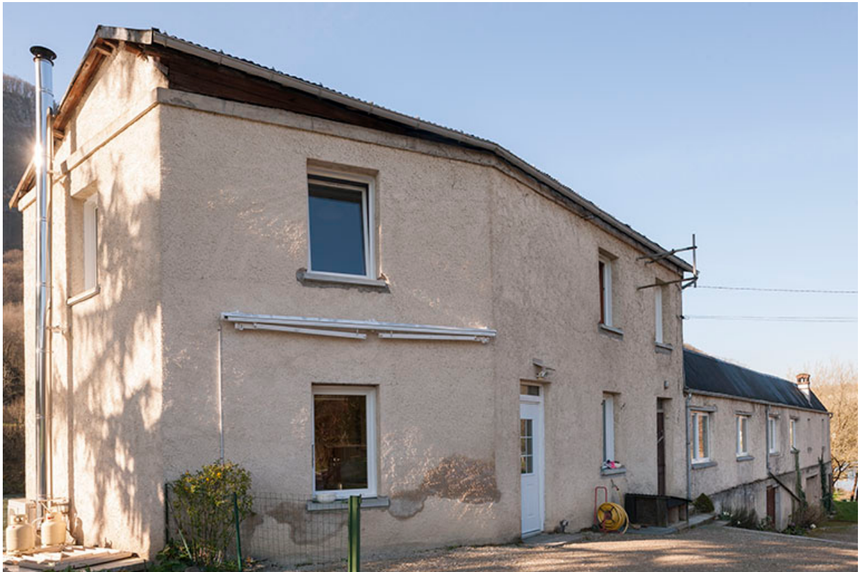
Façade nord du logement et de l'atelier.
