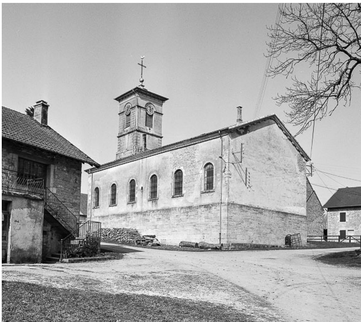
Extérieur : face latérale droite et chevet.
