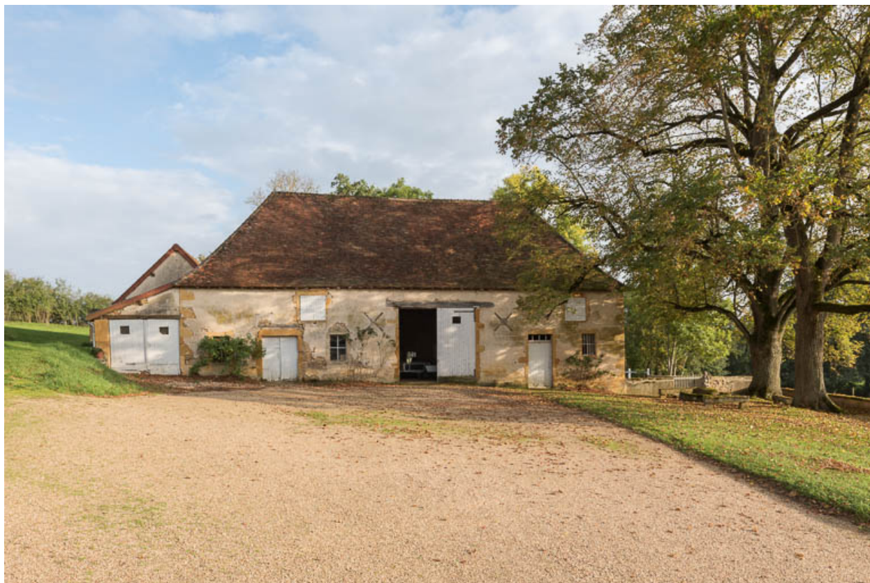
Façade antérieure de la grange
