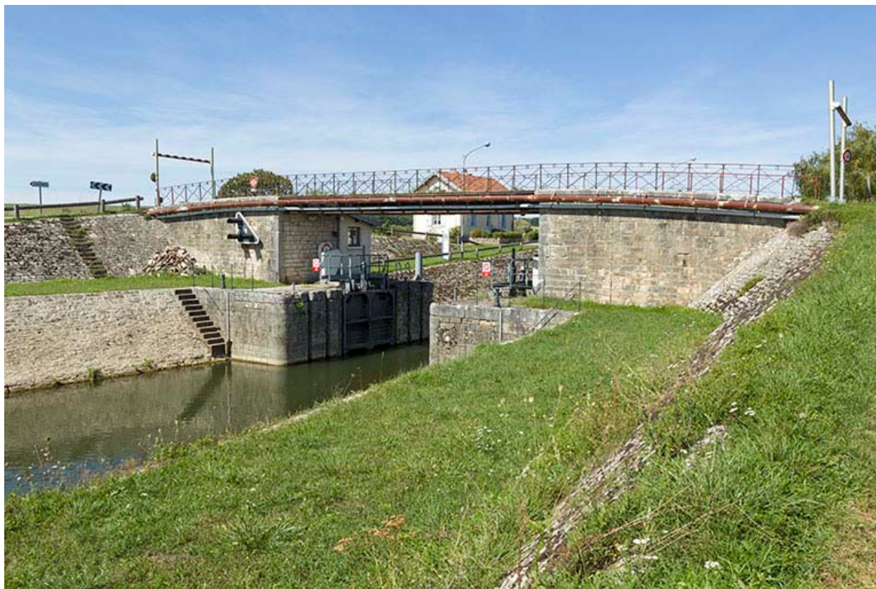
Bief aval de l'écluse.
