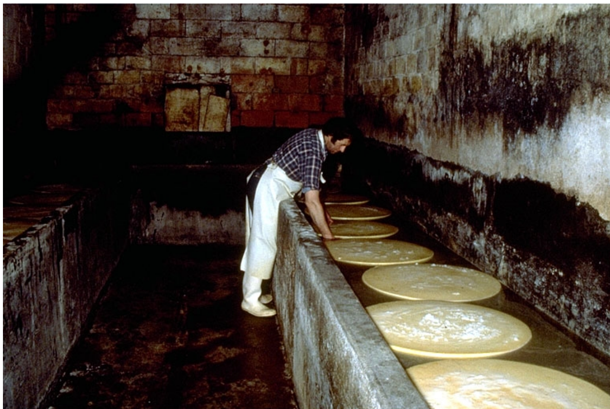
Intérieur d'une cave à saumure, au rez-de-chaussée.
