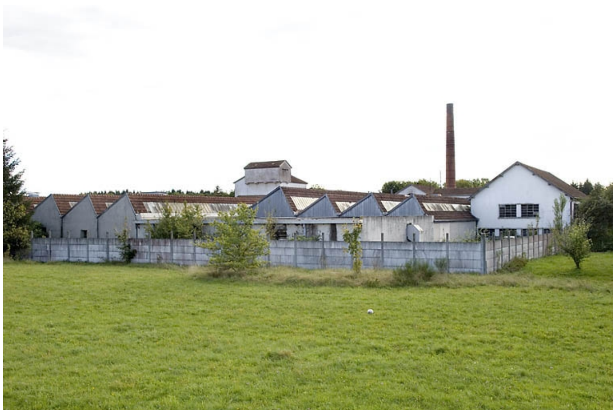
Vue rapprochée depuis le nord.
