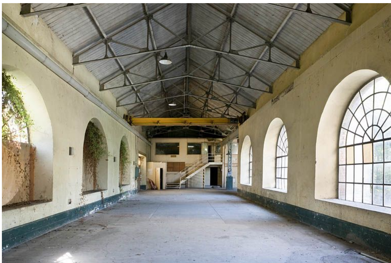
Vue intérieure de la salle des turbines.
