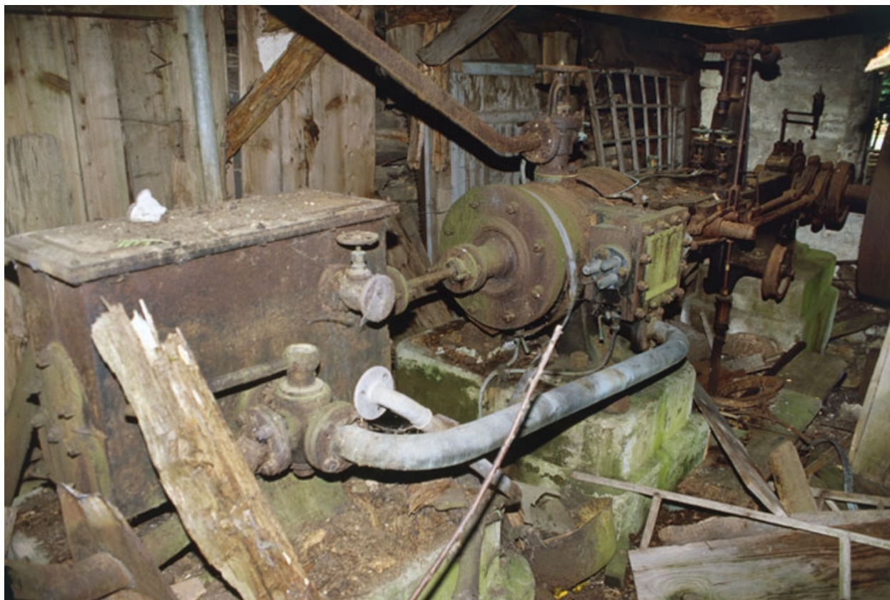
Vue d'ensemble de la machine à vapeur.
