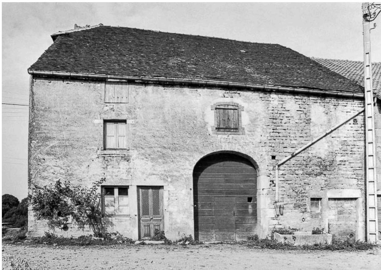
Ferme cadastrée D2 275 : façade antérieure.
