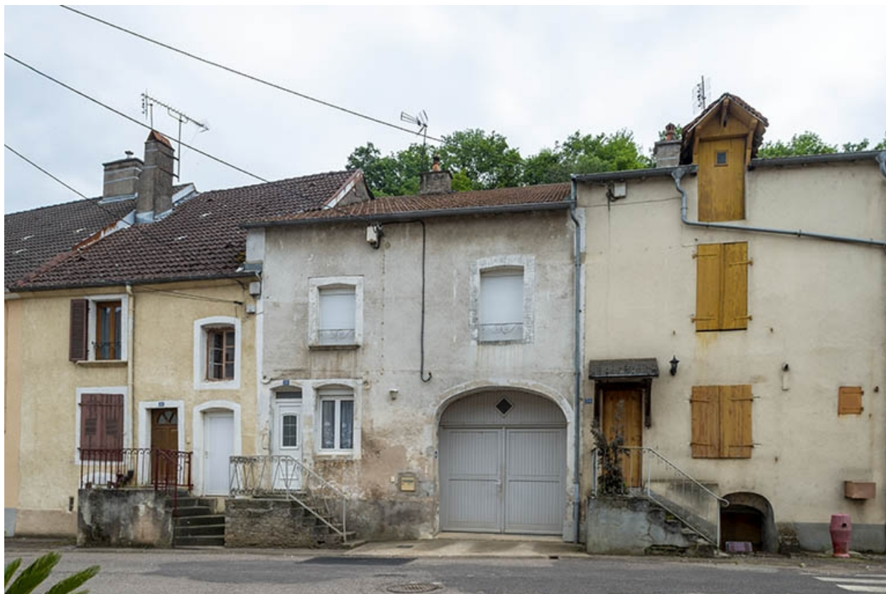
Les n° 36, 38 et 40 de la rue Thiers.
