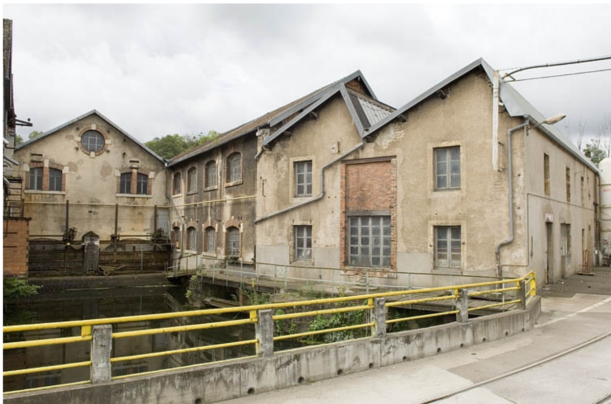
Bief d'amenée, bâtiment d'eau et atelier.
