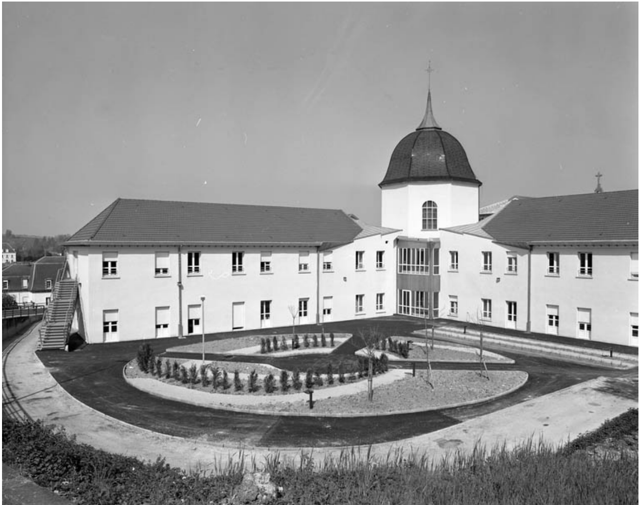
Cour à l'arrière de l'édifice : vue rapprochée.
