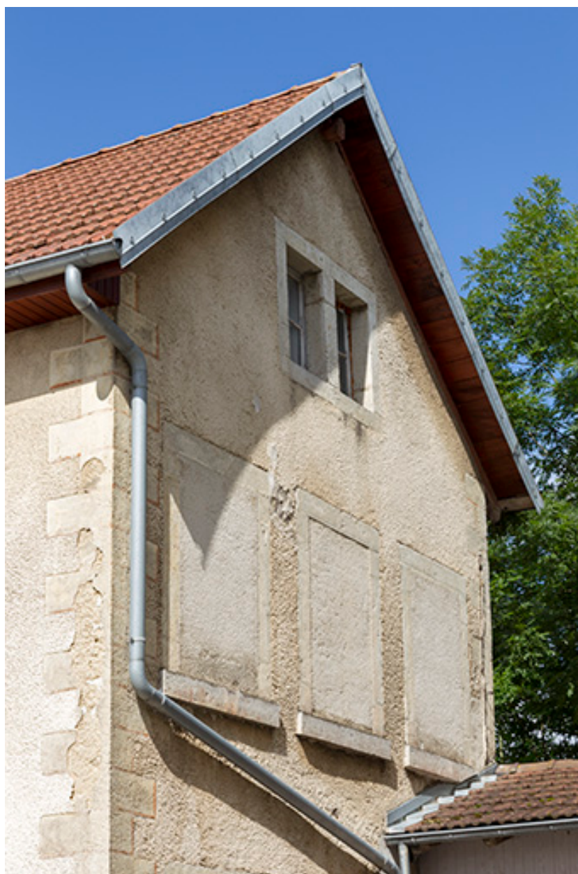
Mur pignon nord-est et ses fenêtres.
