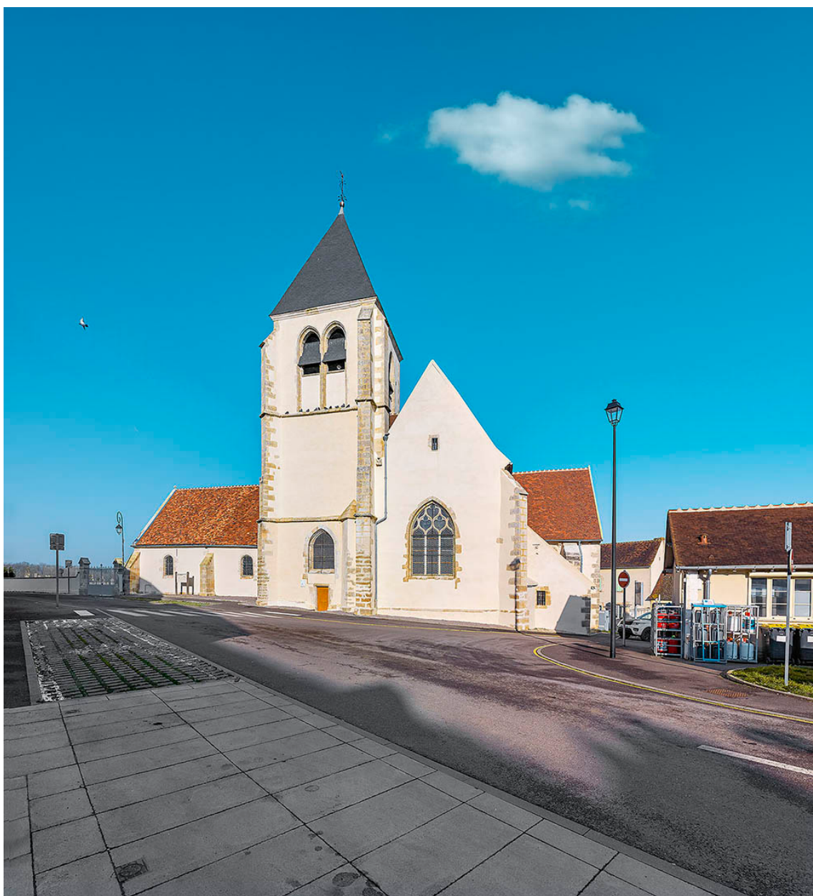
Elévation sud avec clocher.
