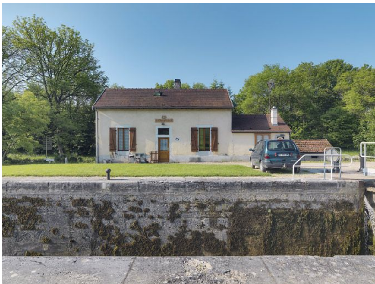
La maison éclusière de face.
