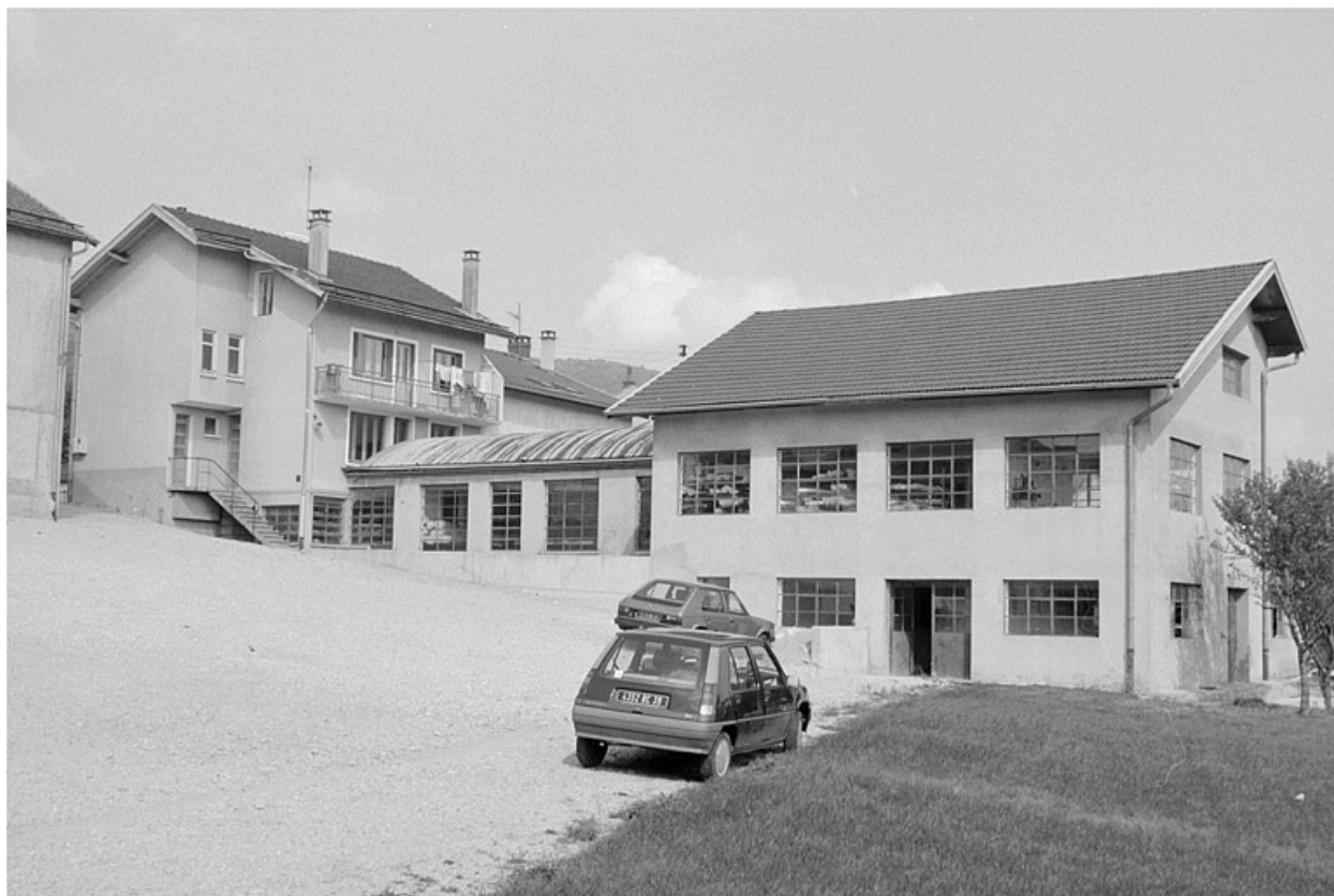
Ancienne tournerie Forestier, vue du sud-est.
