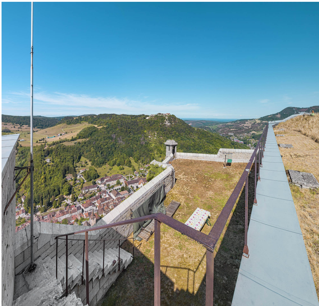
Escalier extérieur de la façade postérieure.
